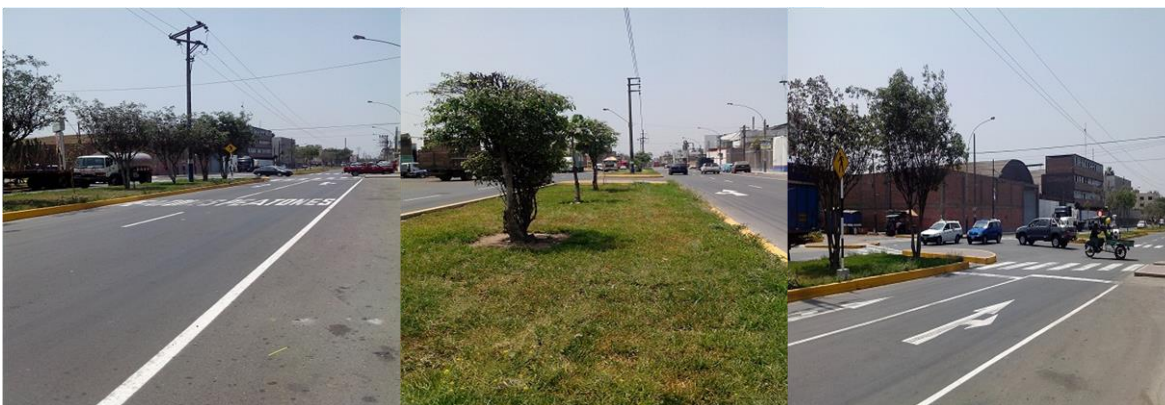
Rehabilitación de pistas, áreas verdes, berma laterales y veredas de la av. Santa Rosa tramo: carretera central - Av. Separadora Industrial, zona 01 distrito de Ate, Lima-Lima con código de SNIP 252627
