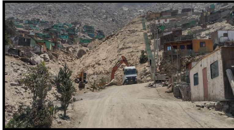
TRABAJOS DE DESCOLMATACIÓN EN EL INICIO DEL CAUCE DE QUEBRADA
