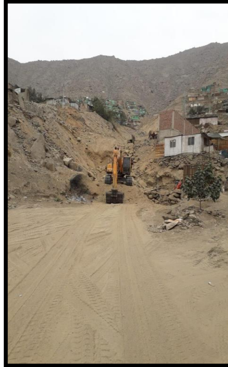
TRABAJOS DE DESCOLMATACIÓN EN EL INICIO DEL CAUCE DE QUEBRADA
