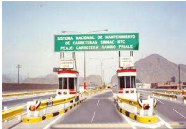
Autopista Ramiro Prialé.
